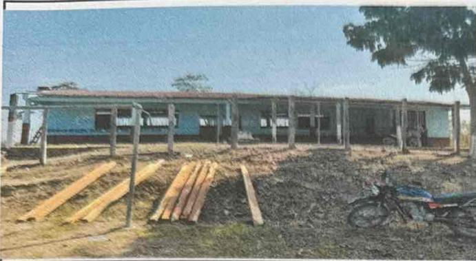
Foto 1: SUSTITUCION DE LAMINAS POR LAMINAS TROQUELADAS
